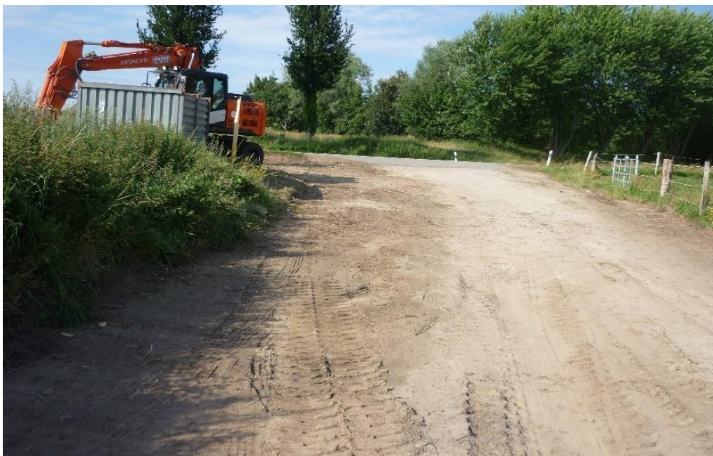
Baubeginn im Juli 2018
