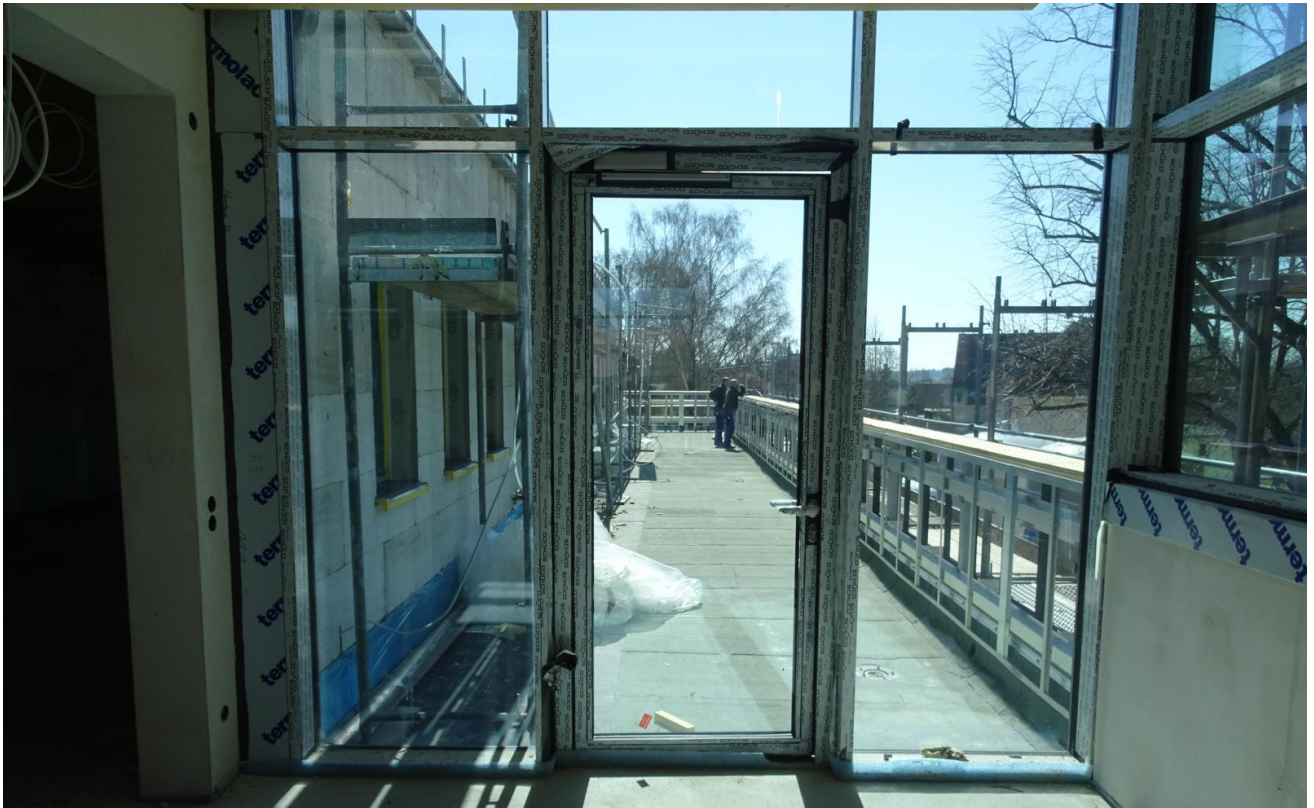
Blick aus dem zukünftigen Wintergarten der Bibliothek auf die Terrasse
