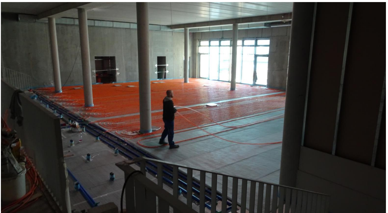
Einbringen der Heizschlaufen für die Fußbodenheizung
