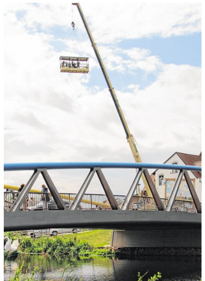
In luftige Höhen entführte die Besucher der Kran.
